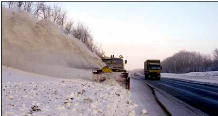
Зимнее содержание федеральной трассы М-5
