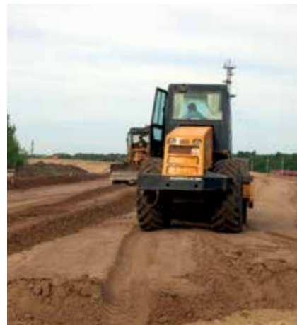
Строительство новых дорог
